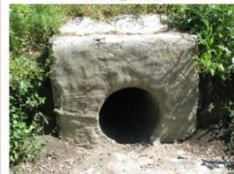
Рис. 2. Выходной оголовок
