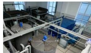
Очистные сооружения ст. Инская
