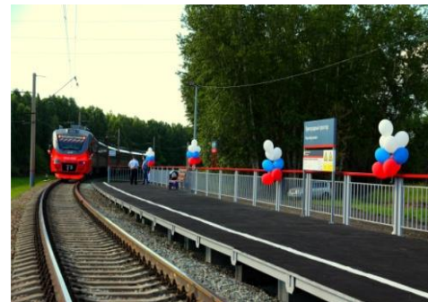
Благоустройство резиновым покрытием о.п. Пригородный простор г. Новосибирск
