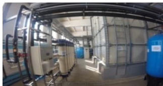
Очистные сооружения ст. Новосибирск-Главный
