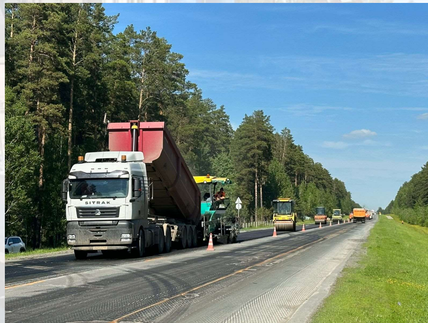
Новосибирская область, 2024 г. (нанесение тонкослойного покрытия на бетон 2007 г. укладки)
