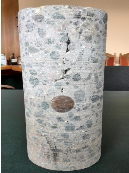
Дефект в бетоне при погружении дюбелей
