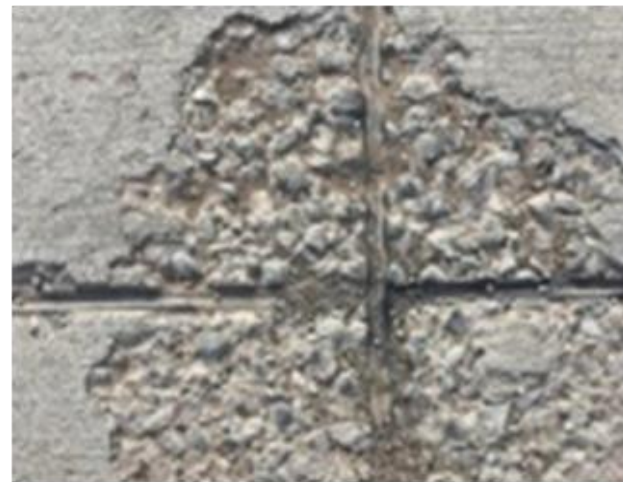
Шелушение и разрушение кромки
