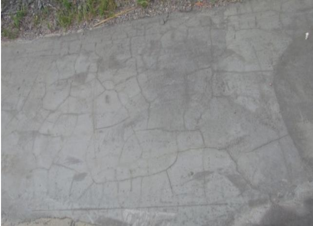
Трещины покрытия
