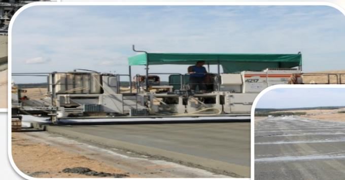
4. Устройство продольных и поперечных (сжатия и расширения) деформационных швов, а также продольного шва на стыке асфальтобетонного и цементобетонного покрытий
