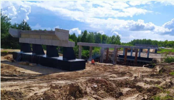
Возведение опор моста (июнь 2022 г.)
