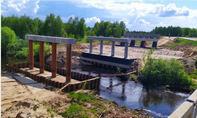
Возведение опор моста (июнь 2022 г.)
