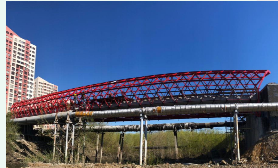
Пешеходный мост через р. Большая Камышная, г. Кемерово Пролет – 52 метра, ширина (диаметр) – в 7,75 метра;
