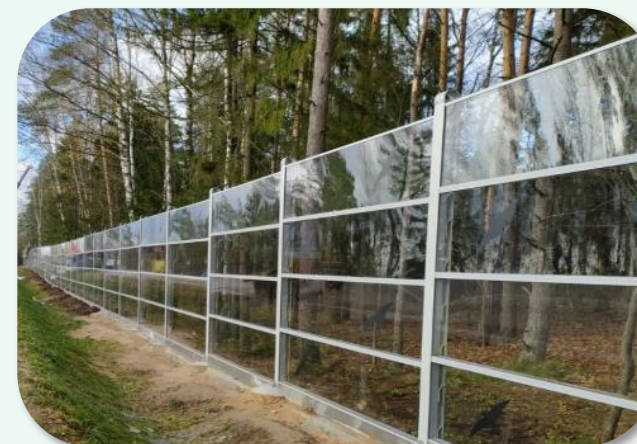
Алюминиевый акустический экран DoorHan РБ Беларусь, Трасса Р-80 Слобода-Паперня. Год установки: 2020
