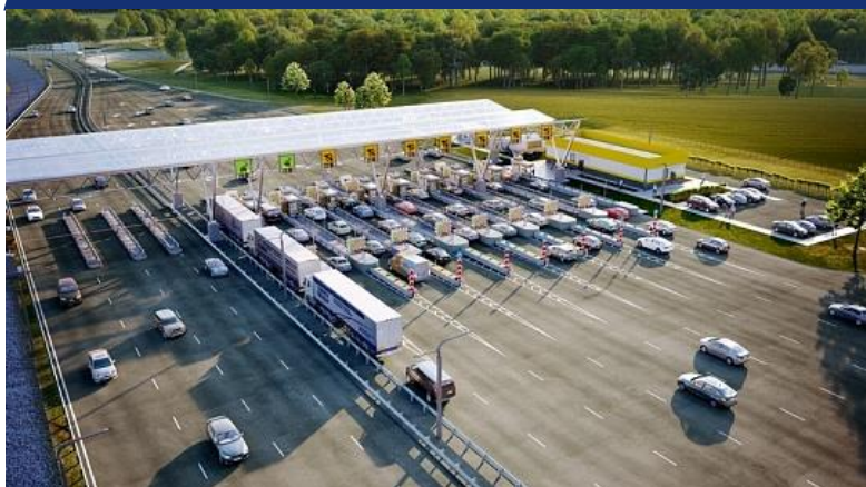
Автодорога «Обход Хабаровска» Сроки строительства: 2017 – 2021 гг.
