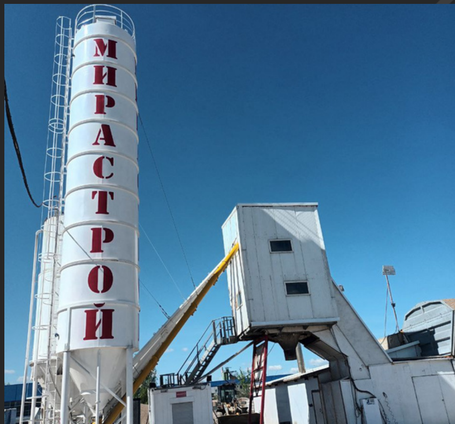
2015 год ПРОИЗВОДСТВО БЕТОНА И СТРОИТЕЛЬСТВО
