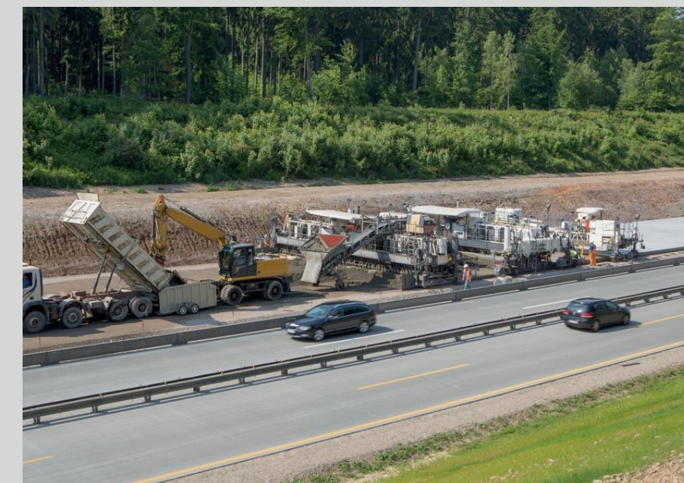
АВТОМОБИЛЬНАЯ ДОРОГА Г. МИРНЫЙ 2020
